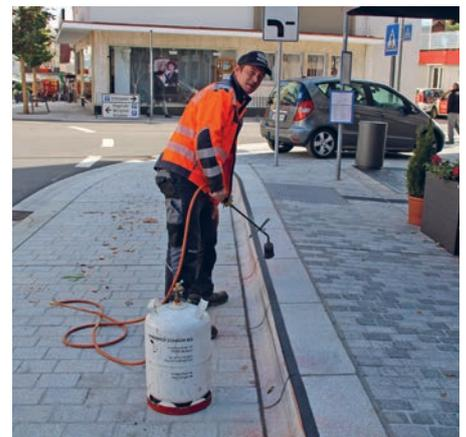
An der Bushaltestelle am Sonnenplatz wurde eine Kontrastmarkierung von den Mitarbeitern des Bauhofs angebracht. Der schwarze Streifen erleichtert Menschen mit Sehschwäche die Orientierung. Jetzt wird die Haltbarkeit der Markierung überprüft.
